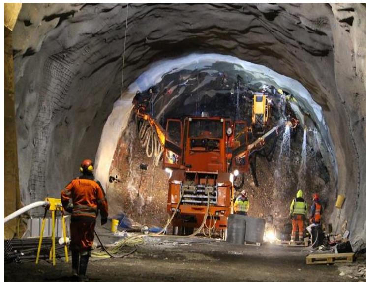
Рисунок 1.3 – Цементация масиву, Vadlaheidi road tunnel, Ісландія (фото з Pi-Jae, Shin, Jun-Ho, Kang, & Young-Ho, Suh, 2005)
