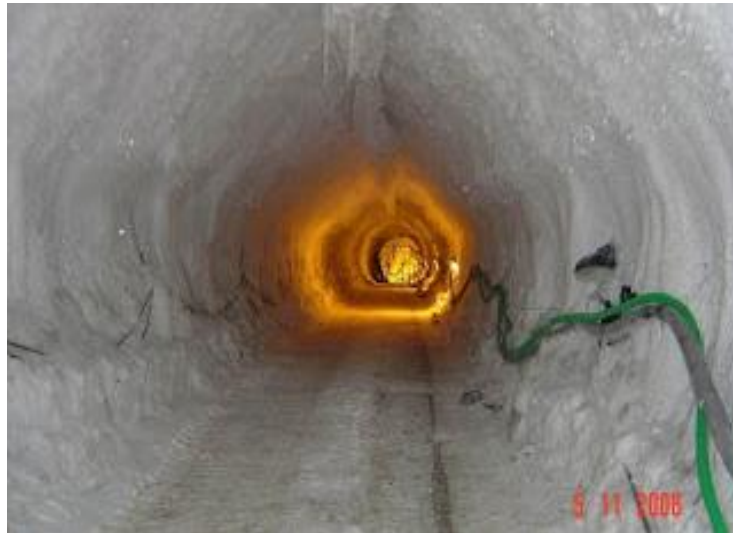
Рисунок 1.2 – Метод штучного заморожування, тунель в Швеції (фото з http://mmmhydropower.blogspot.com/ )
