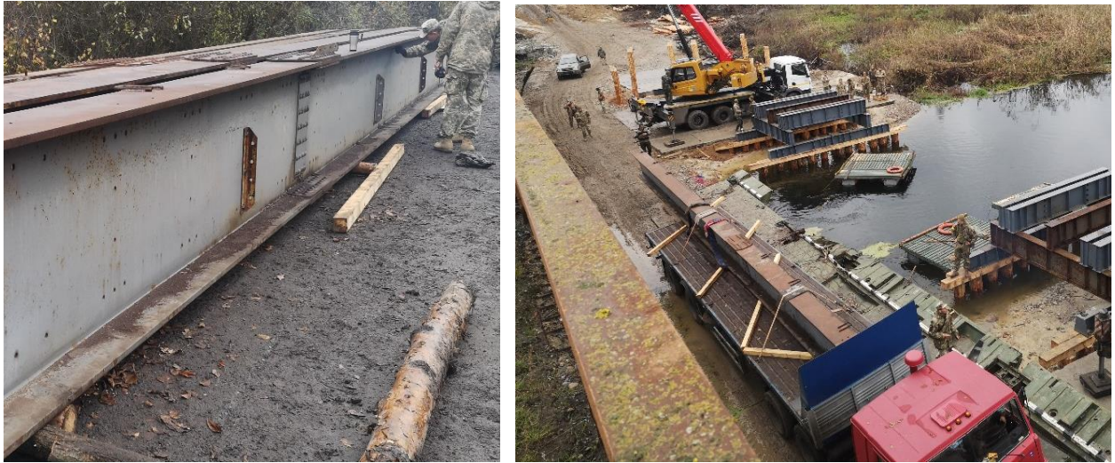
Рисунок 2.7. Підготовка балки для встановлення в прогін (із звіту, жовтень 2022)
