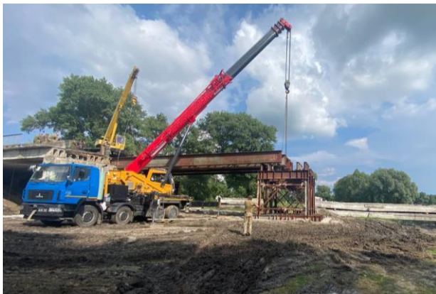
Рисунок 1.6. Використання інвентарних конструкцій
