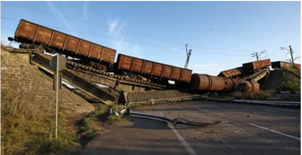
Рисунок 1.3. Зруйнований залізничний шляхопровід під час проходження рухомого складу (із звіту, 2022)
