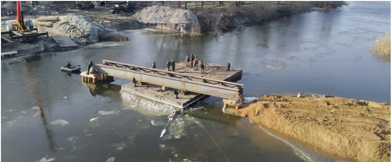
Рисунок 2.6. Встановлення прогонової будови за допомогою плашкоуту (із звіту, жовтень 2022)
