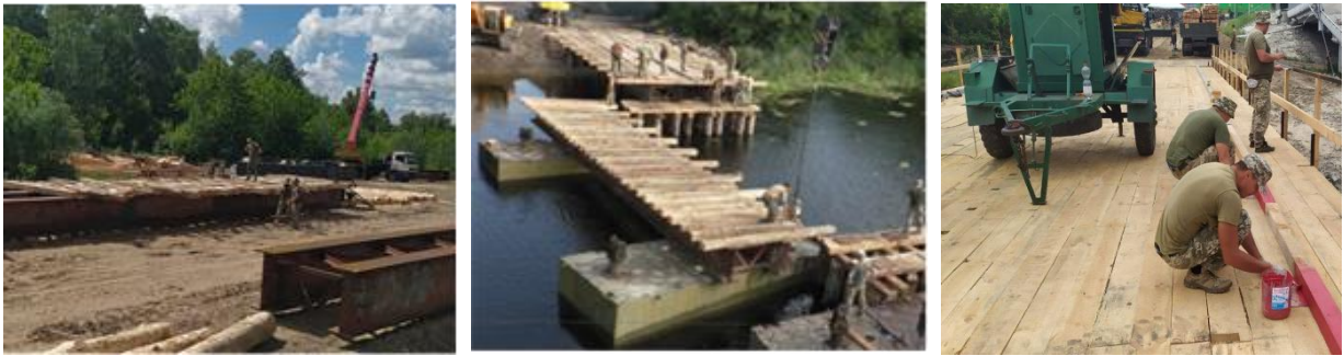
Рисунок 2.4. Етапи спорудження прогонових будов
