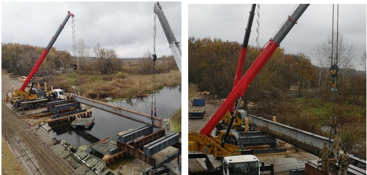
Рисунок 2.8. Встановлення балок прогонових будов в прогін. (із звіту, жовтень 2022)
