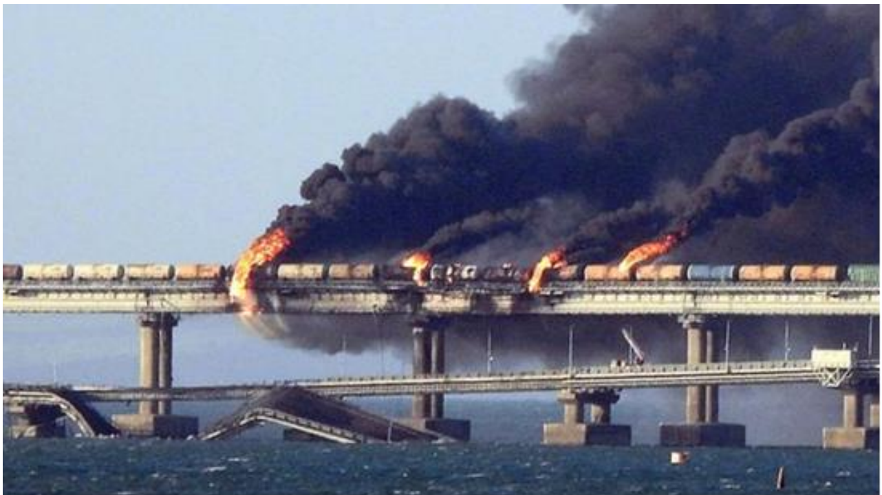
Рисунок 1.2. Пожежа на залізничному прогоні кримського мосту.
