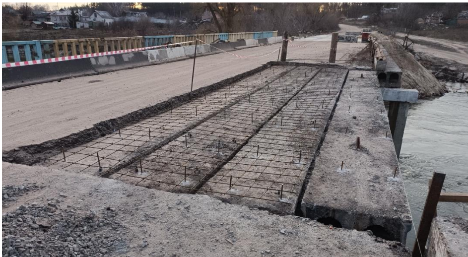
Рисунок 1.8. Використання раніше вживаних залізобетонних балок (із звіту, 2022)
