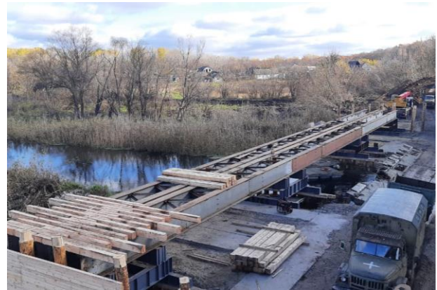
Рисунок 1.6. Використання інвентарних конструкцій
