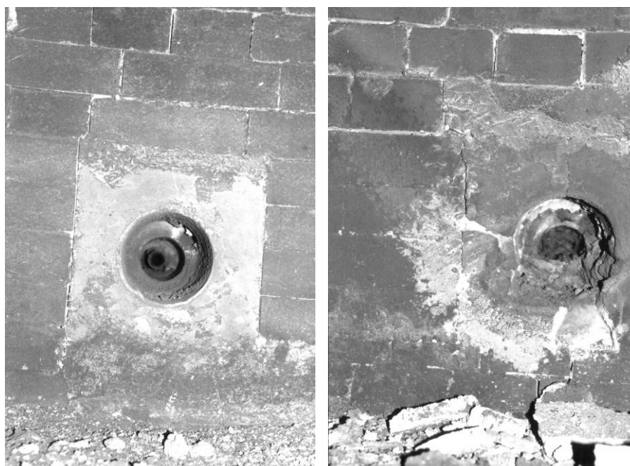
Rys. 4. Kształtki palnikowe i wyloty powietrza palników [6]
